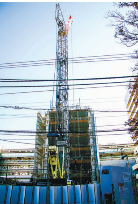
着々と工事が進行中
